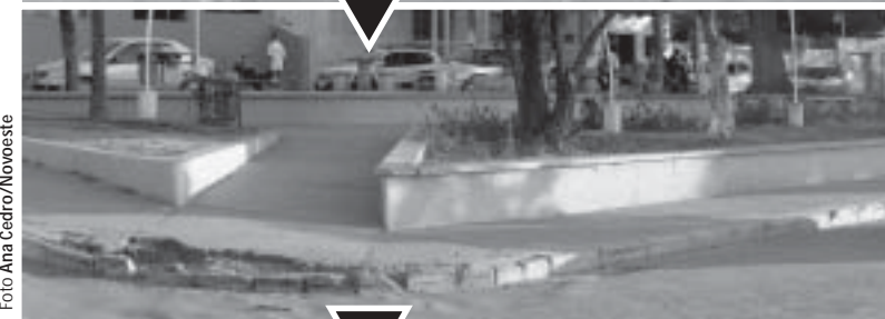
Praça Ten. Cel. Celso: meio fio de lajota de concreto totalmente destruído após substituírem por pedras talhadas na década de 60.
