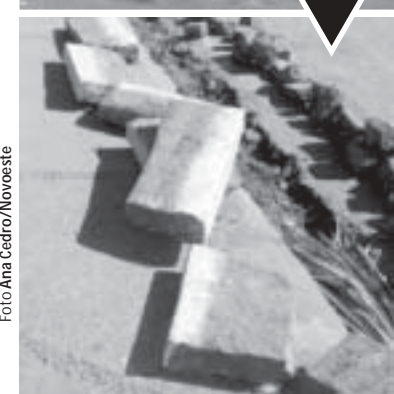
Pedras talhadas: fabricadas na década de 60 compunham o meio fio da Praça Ten. Cel. Celso. Desapareceram após serem desnecessariamente substituídas por lajotas de concreto.
